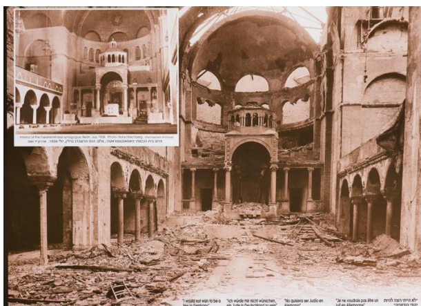
Sinagoga Fasanenstrasse destruida
